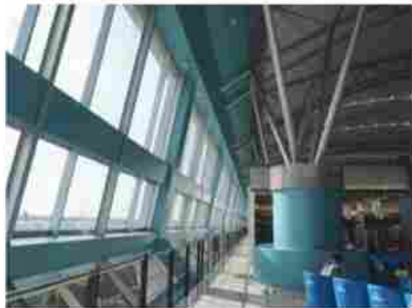
Pemanfaatan cahaya matahari untuk penerangan terminal
